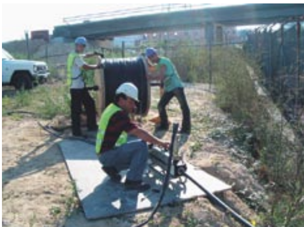
Rede de investigação e ensino: trabalho de construção Research & education network: construction site
