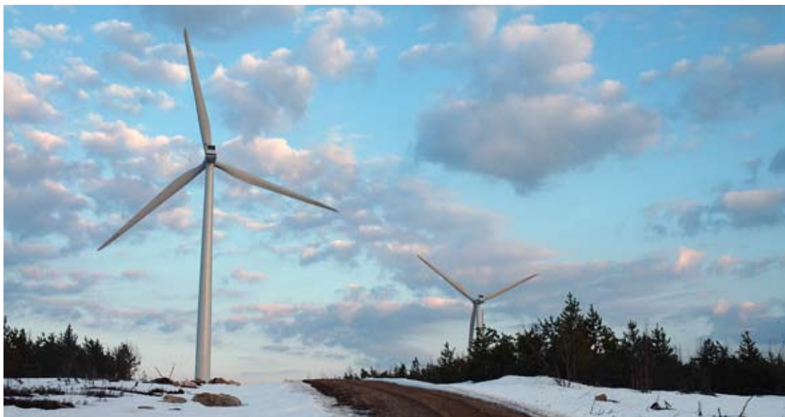
Vindkraftverken i Aapua är utrustade med uppvärmning för nacell, anemometer och vindfana. Det möjliggör att verken kan generera el i temperaturer ner till -40^{\circ}\text{C} .
