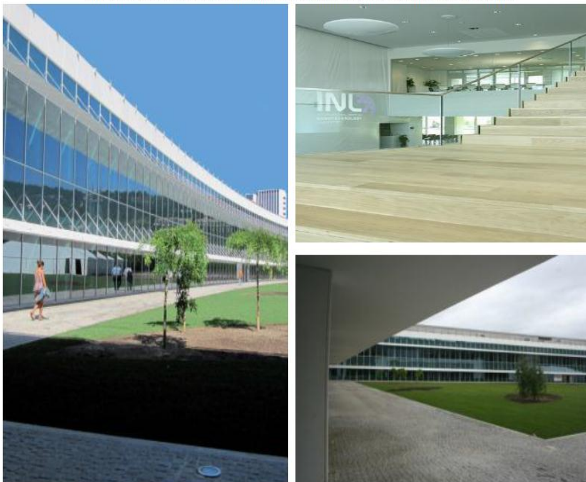
Fotografias do edifício principal do INL a partir do pátio interior e do hall de entrada do edifício principal:
