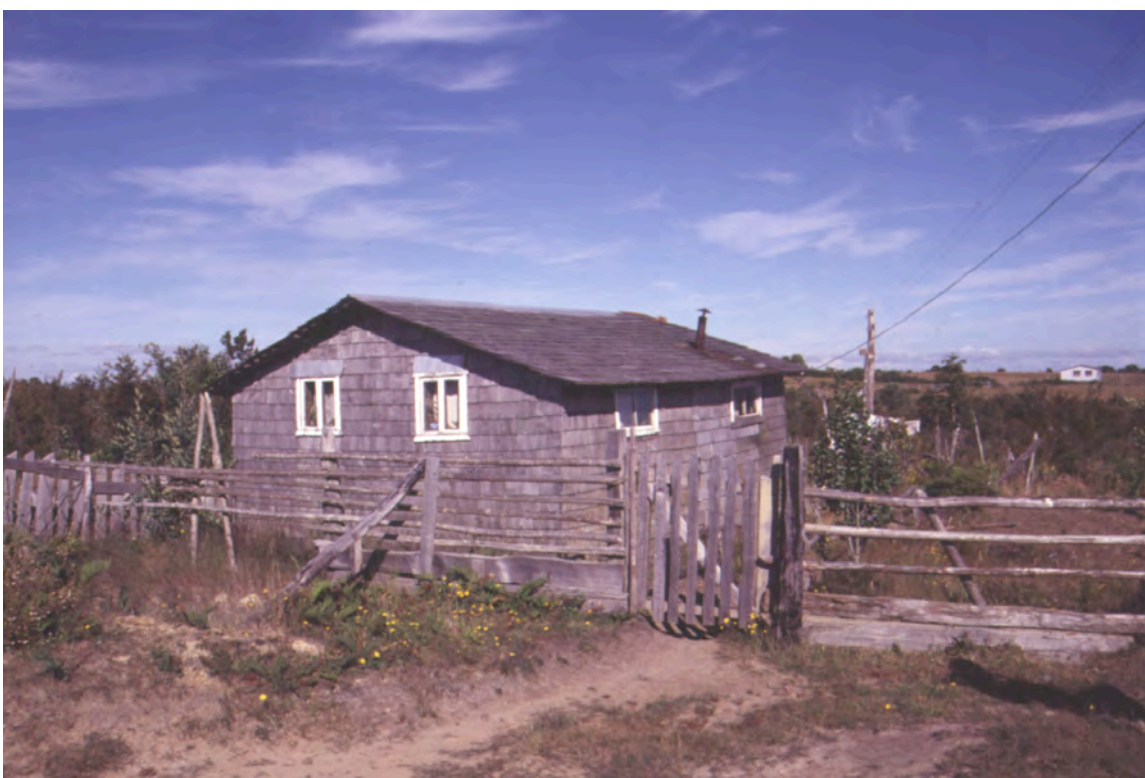
Fot. 8 - Habitação coberta e revestida a “tejuela”.
