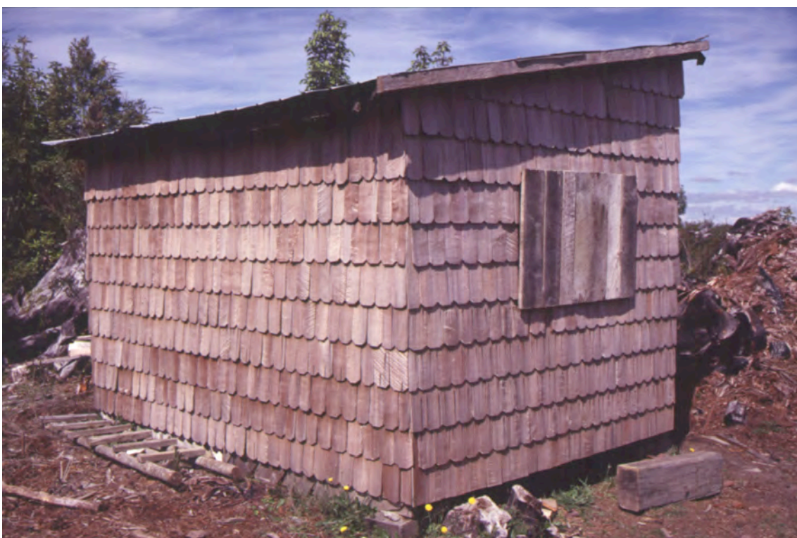
Fot. 10 - Pormenor da fot.11, mostrando o revestimento das paredes do barracão, a “tejuela”.
