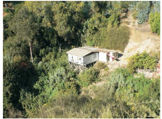
Fot. 2.- Ocupación de terrenos en sectores de altas pendientes y vegetación densa. Los espacios utilizados caen fuera de aquellas áreas legalmente habilitadas para uso urbano.
