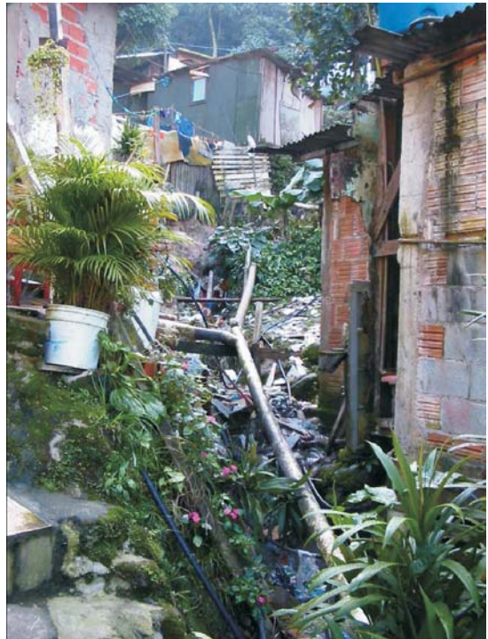
Fot. 1 - Processo de favelização no Vale da Morte, bairro serrano do município de Guarujá, Brasil. Fonte: Araki, 2007.
