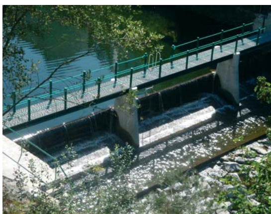
Fot. 23-B - Pormenor da nova solução adoptada, pontão e açude independentes. (06 de Setembro de 2009)
