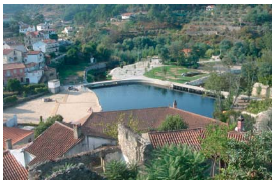
Fot. 8-B - Vista geral da praia fluvial, em Setembro de 2009, após as últimas obras de reabilitação.
