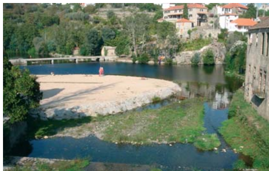
Fot. 7-B - Idem, em Setembro de 2009, após as últimas obras de recuperação, realizadas na sequência das cheias de 2006.
