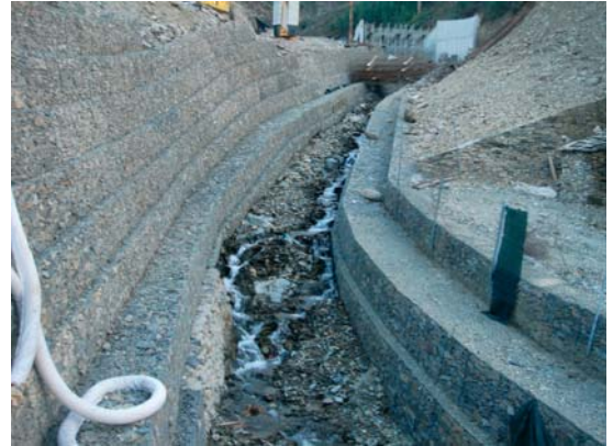
Fot. 16 - Pormenor da execução das obras na área do antigo parque de estacionamento. Fot.: Eng. a Carla Neves, Câm. Mun. Arganil.
