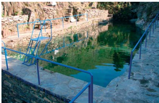
Fot. 19 - Aspecto da piscina, após a recuperação efectuada cerca de três anos depois (16 de Julho de 2009). Fonte: http://blog.soitodaruiva.com/?pg=viewPost&id=94
