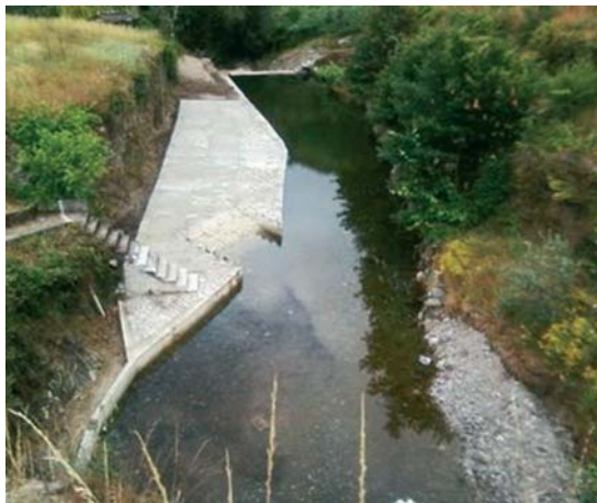
Fot. 21 - Aspecto actual da piscina, após a reabilitação realizada três anos depois (27 de Junho de 2009).
