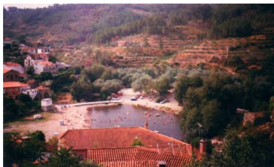
Fot. 8-A - Vista da praia fluvial de Avô, anos depois das primeiras obras de recuperação.
