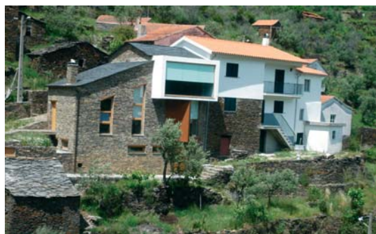
Tot. 14-A e B - Vista geral do CIAM, antes e depois das obras de reabilitação.
